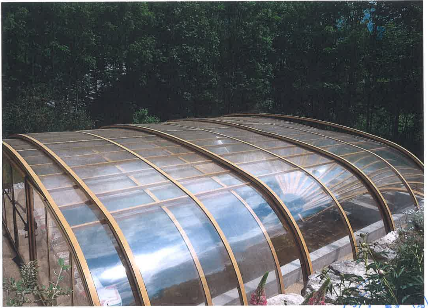
Piscine et son abri
