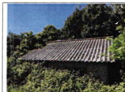
Photo n° PhA001 Localisation : Rez de chaussée - Bâtiment Ouvrage : Toitures Partie d'ouvrage : Plaques (fibres-ciment) Description : Plaques (fibres-ciment) Localisation sur croquis : 001
