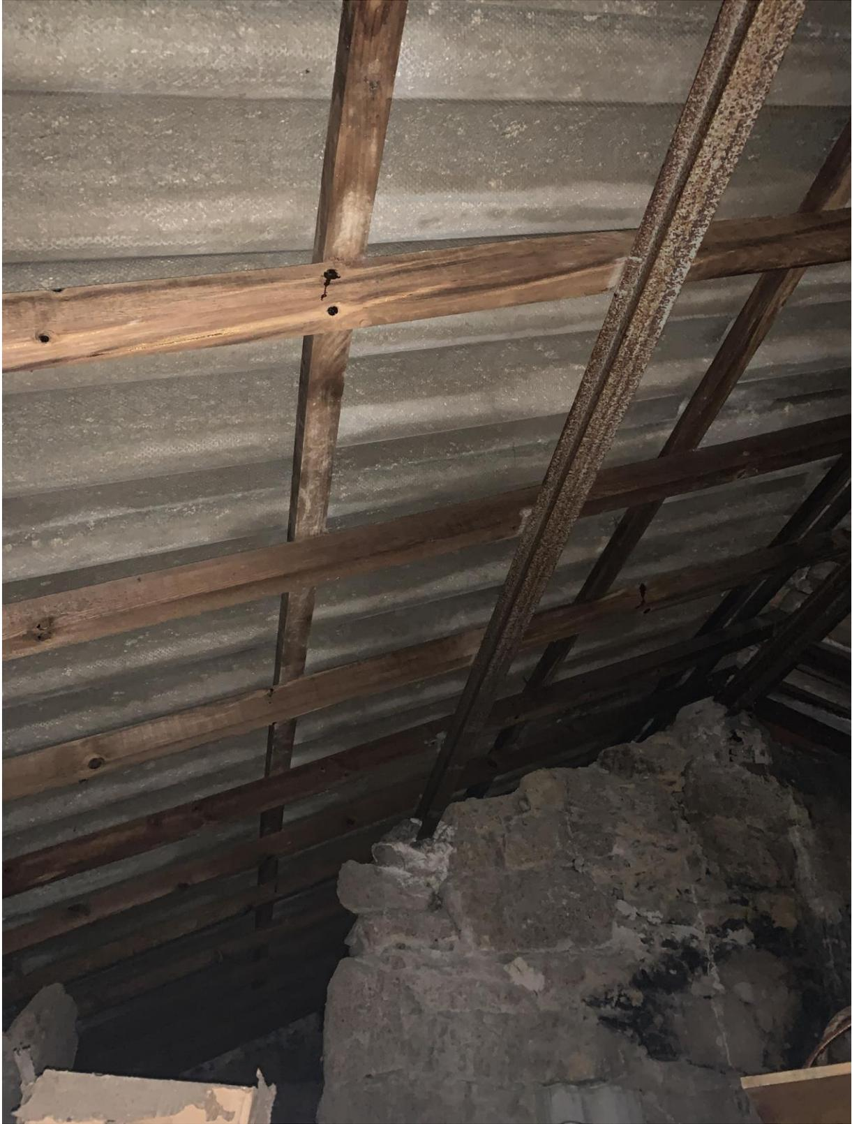
Je constate des poutres en bois et des tôles en fibre ciment.
