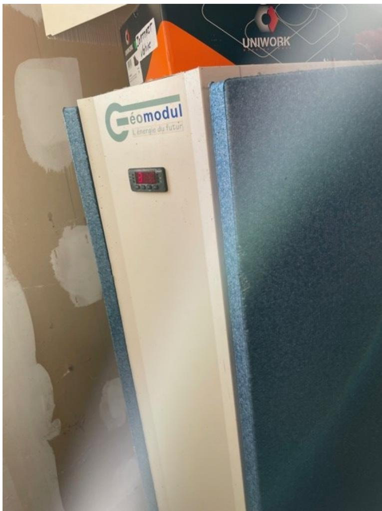
Système de géothermie en réseau fermé eau / eau
