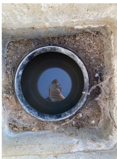
Photo 3 : Regard de répartition en charge
