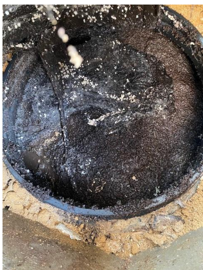
Photo 2 : Fosse toutes eaux
