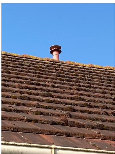
Photo 5 : Ventilation secondaire
