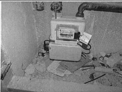
Photo n° du Compteur Gaz
