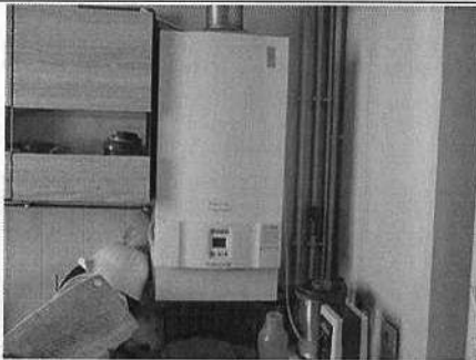
Photo n° PhGaz001 Localisation : Cuisine Chaudière DE DIETRICH (Type : Raccordé) Localisation sur croquis : Point001
