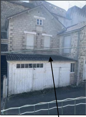
Photo N° 001BAT 1-Ext.-Toiture Nord_BAT 1_Ext.-Toiture-Plaques ondulées de type "fibres ciment contenant de l'amiante" (Fibres-ciment)
