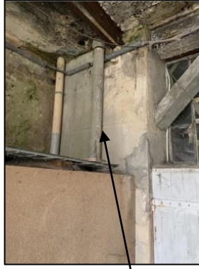
Photo N° 002BAT 2-S.sol-Porche_BAT 2_S.sol-Conduits de fluide-Conduit vertical de type "fibres ciment contenant de l'amiante" (Fibres-ciment)
