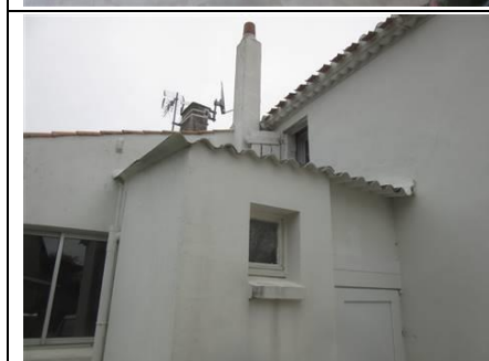
Photo n° Ph004 Localisation : Rez de chaussée - Wc Ouvrage : 1 - Couvertures, Toitures, Terrasses et étanchéités - Plaques ondulées et planes Partie d'ouvrage : Plaques en fibres-ciment (y compris plaques « sous tuiles ») Description : Toiture au niveau des Wc en plaques ondulées en amiante-ciment
