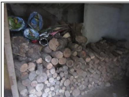
Photo n° Ph001 Localisation : Extérieur - Débarras à bois Ouvrage : Sol - Béton Mur - Enduit Plafond - Eléments de charpente Porte(s) en PVC Autre - Remarque : Présence de stockage bois
