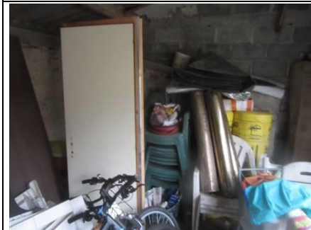
Photo n° Ph002 Localisation : Extérieur - Débarras 2 Ouvrage : Sol - Béton Mur - Parpaings Plafond - Eléments de charpente Fenêtre - Baie(s) en aluminium Autre - Remarque : Présence d'encombres
