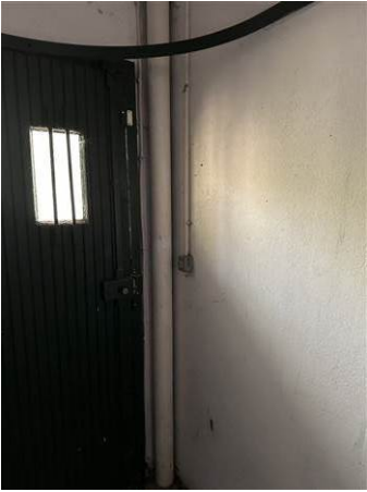
Photo n° R2 Localisation : Rez de chaussée - Garage Ouvrage : Conduit - Fibrociment Partie d'ouvrage : Conduit - Fibrociment Description : Conduit - Fibrociment et Peinture
