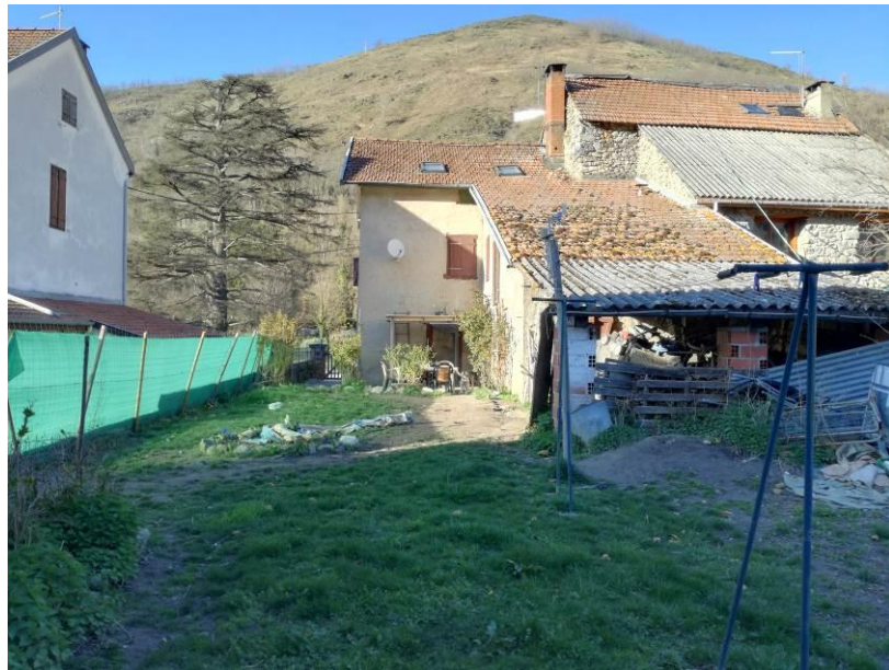
Façade Côté Sud
