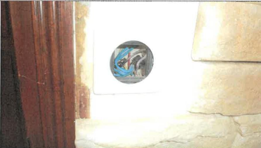
**Description :** L'installation électrique comporte au moins une CONNEXION avec une partie active nue sous tension accessible.
