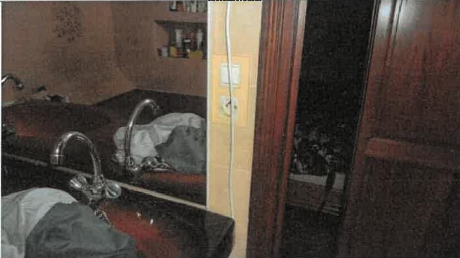
**Description :** Local contenant une baignoire ou une douche : l'installation électrique ne répond pas aux prescriptions particulières appliquées à ce local (adéquation entre l'emplacement où est installé le MATERIEL ELECTRIQUE et les caractéristiques de ce dernier – respect des règles de protection contre les chocs électriques liées aux zones).
