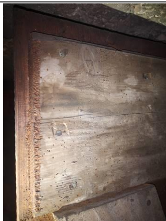
Photo n° PhTer001 Localisation : Sous-sol - Cave - Chaufferie - Buanderie Ouvrage : Portes - Bois Parasite : Anobium punctatum (Petites vrillettes) Indices : présence de trous de sortie (présence sur une partie de l'élément)
