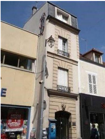
Photo PhDPE002 Ouvrage : Sud
