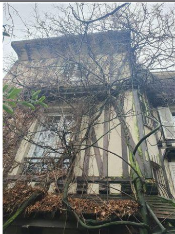
Photo PhDPE001 Ouvrage : Nord
