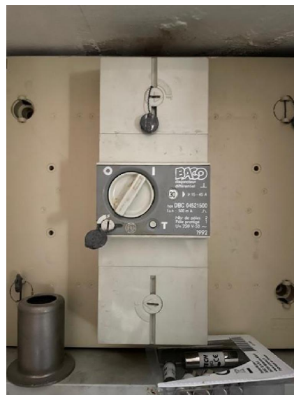
B.2.3.1 i) : La manoeuvre du bouton test du (des) dispositif(s) de protection différentielle n'entraîne pas (son) leur déclenchement.
