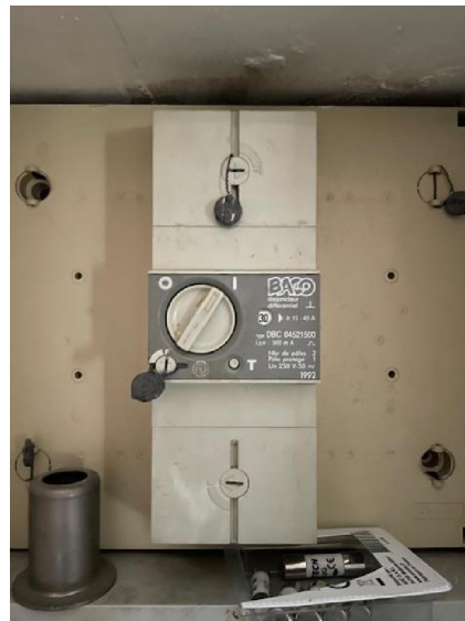
B.2.3.1 h) : Au moins un dispositif de protection différentielle ne fonctionne pas pour son seuil de déclenchement.
