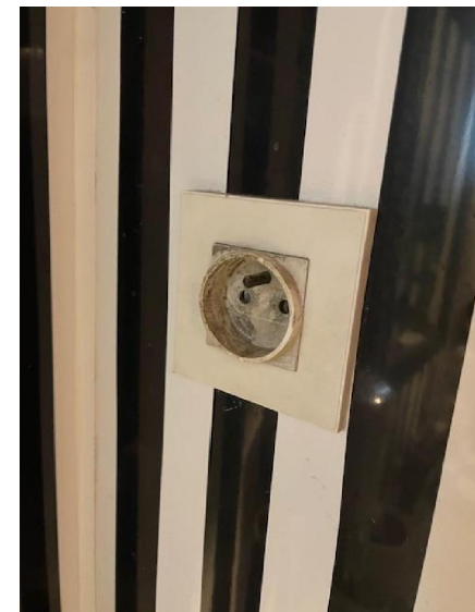
B.6.3.1 a) : Local contenant une baignoire ou une douche : l'installation électrique ne répond pas aux prescriptions particulières appliquées à ce local (adéquation entre l'emplacement où est installé le matériel électrique et les caractéristiques de ce dernier - respect des règles de protection contre les chocs électriques liées aux zones).
