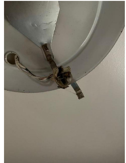
B.7.3 d) : L'installation électrique comporte au moins une connexion avec une partie active nue sous tension accessible.
