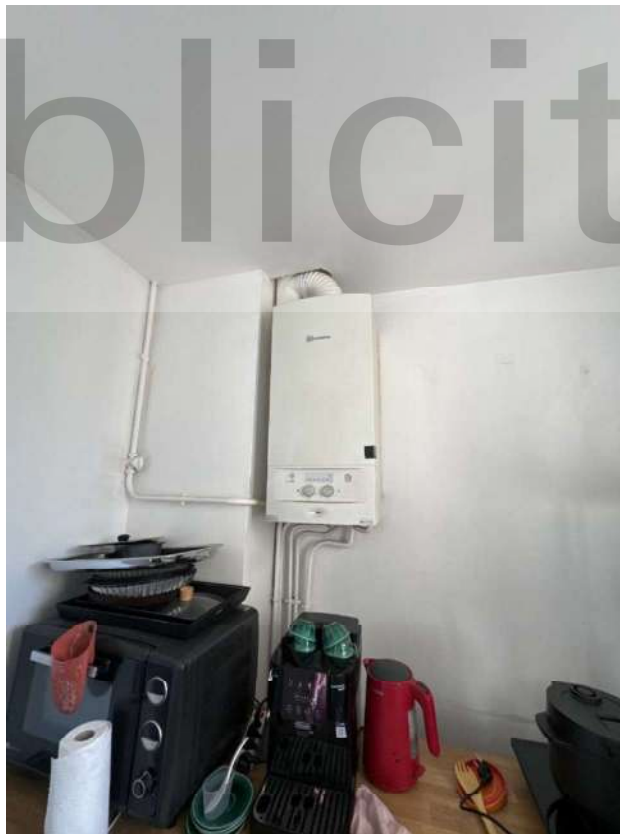
La chaudière gaz à production d'eau chaude est installée dans la cuisine.
