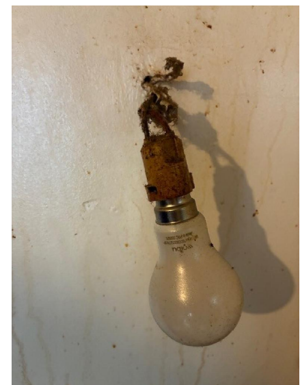
B.8.3 b) : L'installation comporte au moins un matériel électrique inadapté à l'usage.
